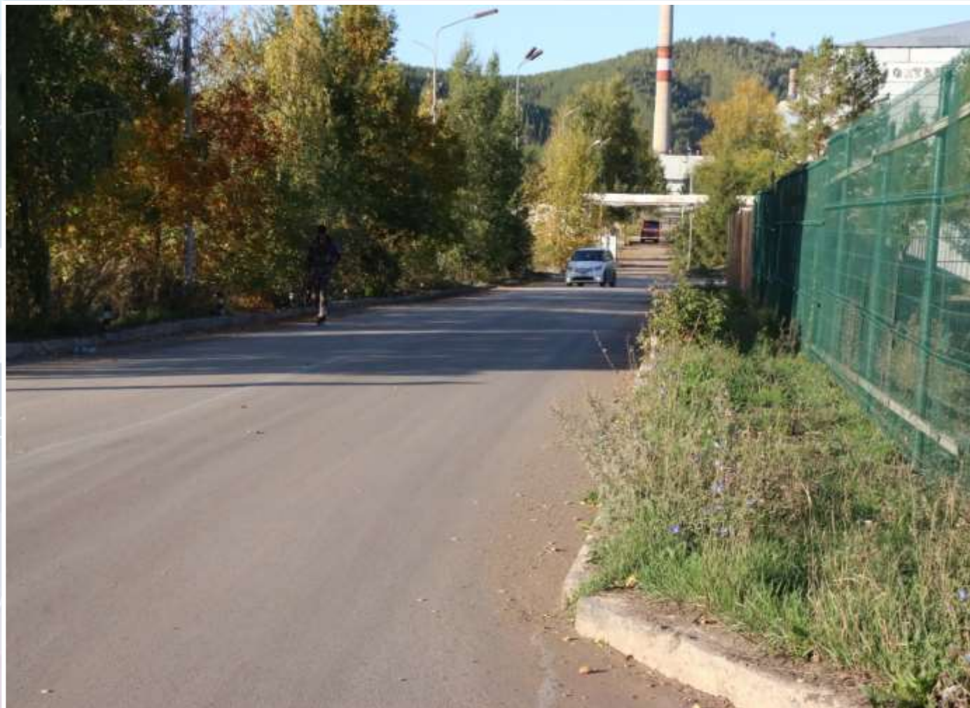
Ремонт участка дороги по ул. Космонавтов от перекрестка с пр. Ленина
